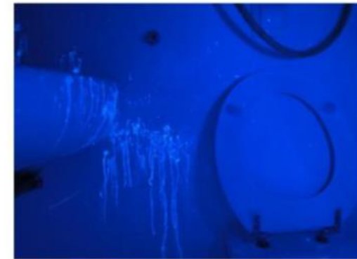
Photo 2 – Après rinçage du bassin
